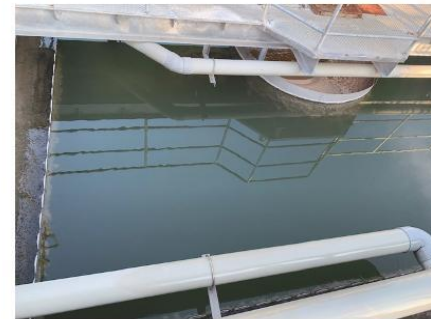
導入後の沈殿槽
