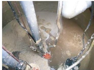
オゾン反応槽での酸化処理
