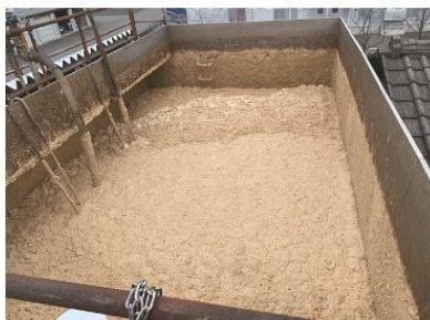
導入前の曝気槽
