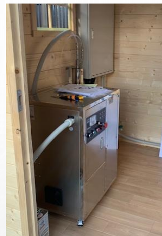
オゾン発生装置
