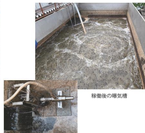
オゾン反応槽の MNB 装置
